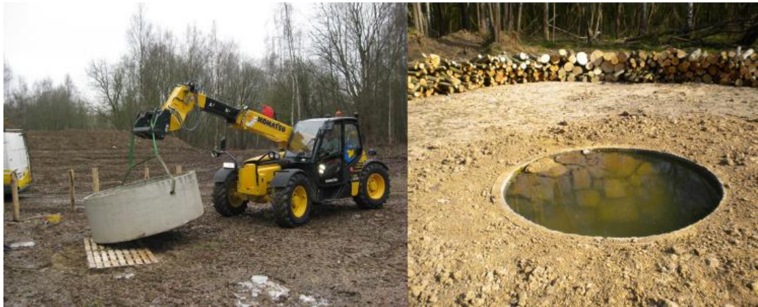
Figuur 40: Aanleg van betonnen voortplantingspoel voor Vroedmeesterpad (Bron Regionaal Landschap Dijleland)
