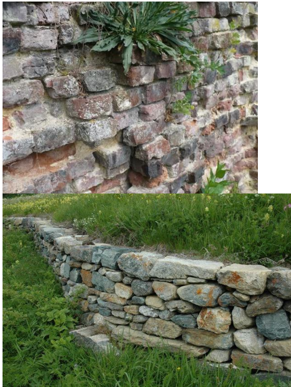
Figuur 43: Oude muren met holtes of aangelegde stapelmuren vormen een prima landbiotoop voor de Vroedmeesterpad.
